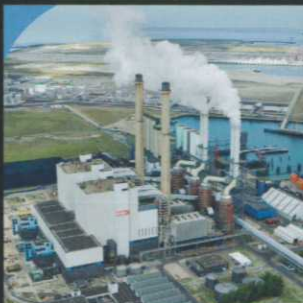
Energie & Rotierende Anlagen
